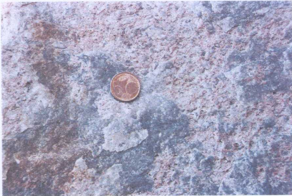
FOTO 3 Detalle de costras con carbonato en plano de fractura
