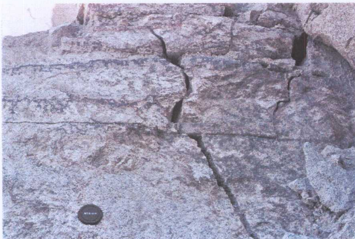
FOTO 5 Plano de fractura. Detalle de irregularidades y restos de espejos de fractura
